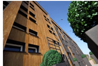
BYDGOSZCZ BUSSINES CENTER at 8 Przemysłowa Street - area: 3 000 sqm
